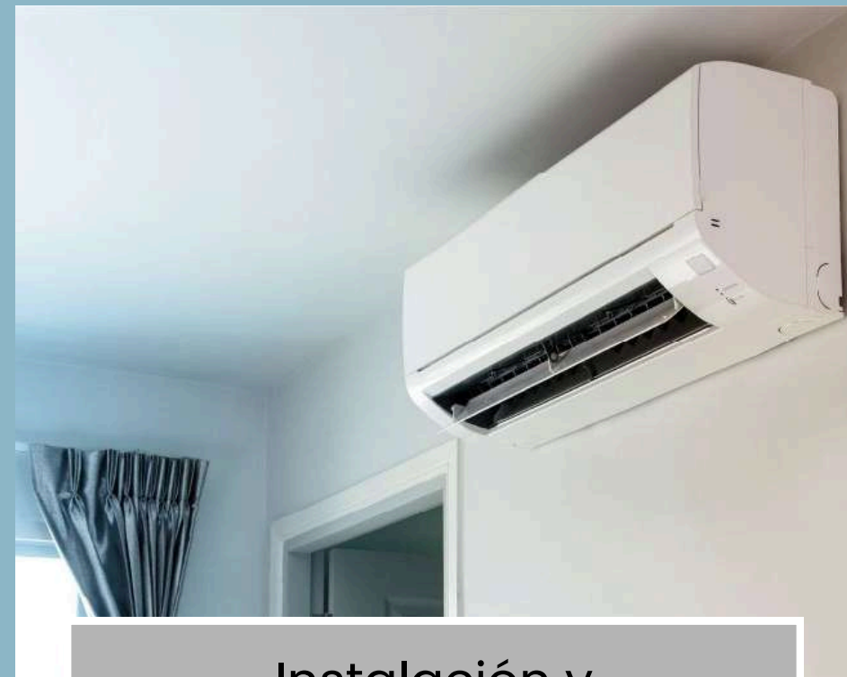
Instalación y mantenimiento de aire acondicionado
