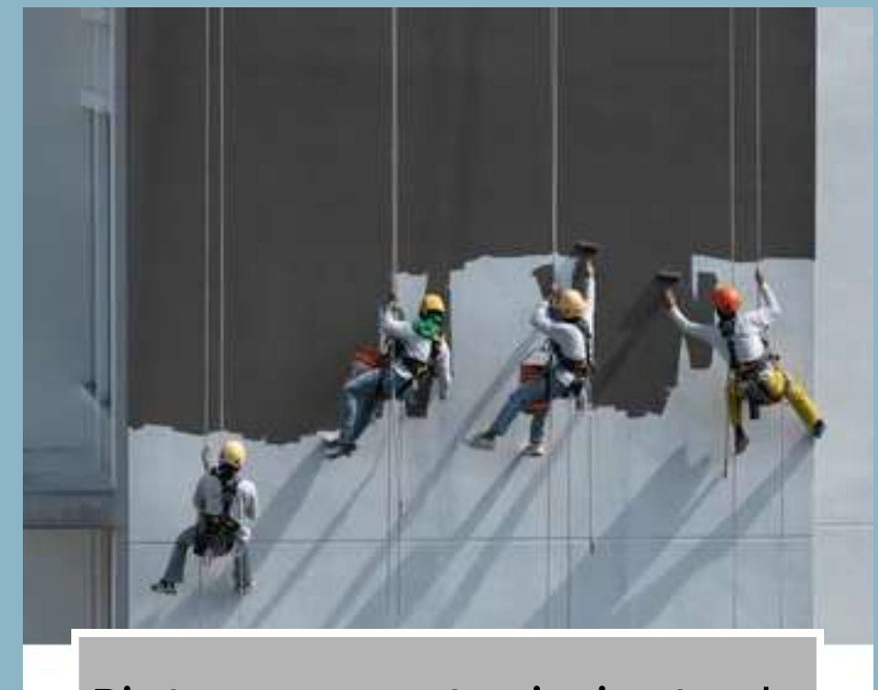
Pintura y mantenimiento de fachadas en altura
