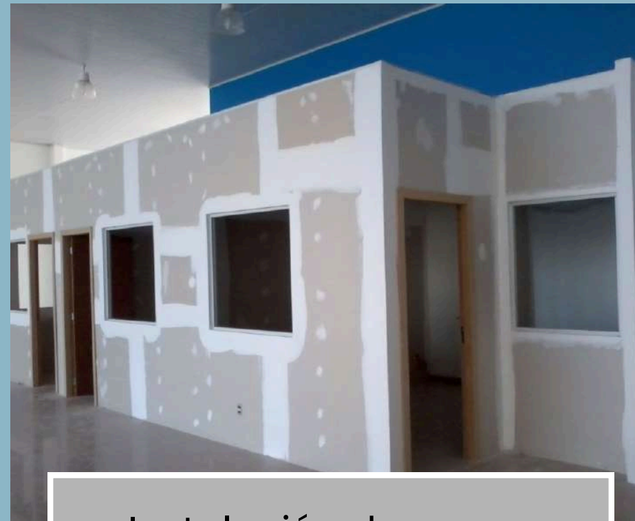
Instalación de casas, oficinas y techos de drywall
